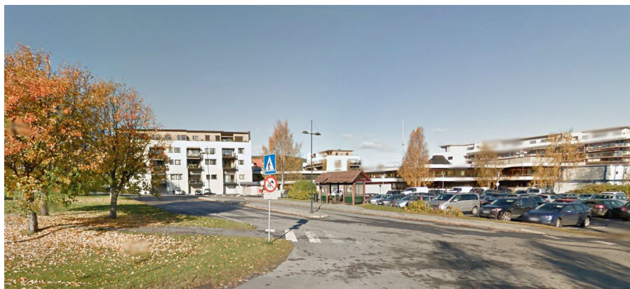
Eksisterende kollektivterminal i Jevnaker sentrum, sett fra Brugata.
