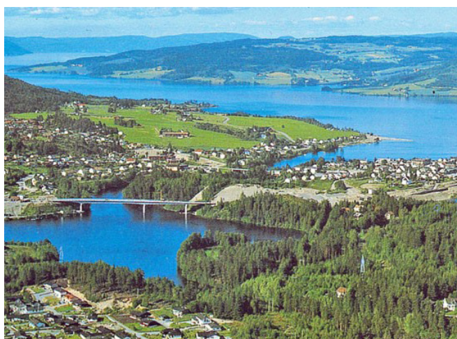
Ny riksveg 35 anlegges langs Hermannstjern og Nybrua bygges over Randselva. Kilde: Kulturhistorisk vurdering Nesbakken 2014.
