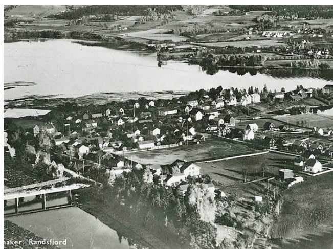
Bilde av bebyggelsen på Nesbakken på trettitallet. Fotballbanen ligger midt i bildet og ny bru er under konstruksjon. Kilde: Kulturhistorisk vurdering Nesbakken, 2014.
